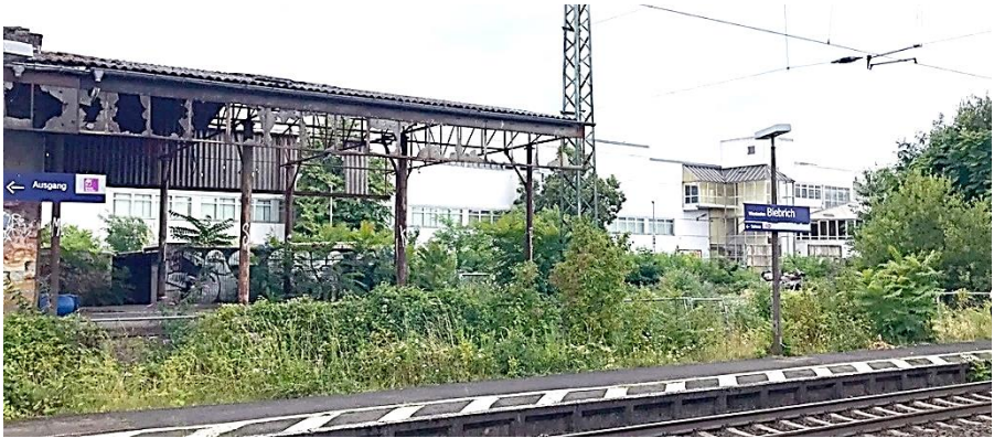
Blick auf den Bahnhof Biebrich
