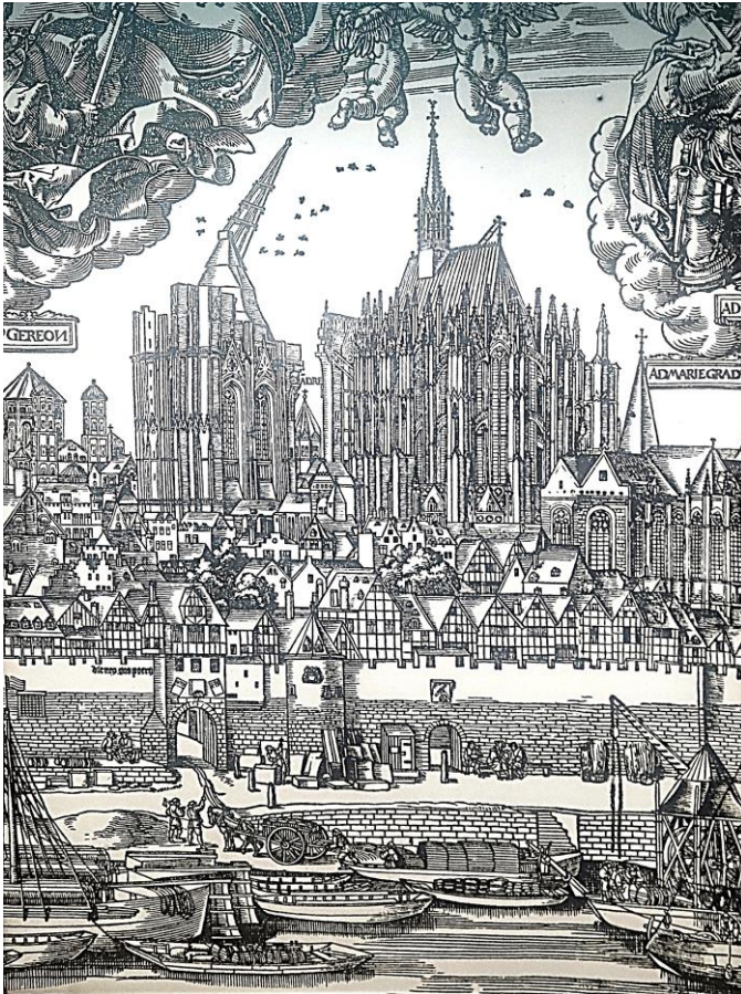
Unfertiger Dom mit Baukran
